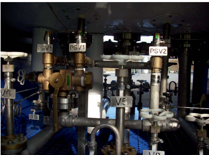
Figura 8. Válvulas de seguridad y dispositivo apagallamas de venteo. Fuente: Autores.
